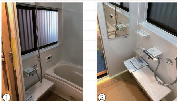
ここでは、器具面に全幅の窓が設置されている間取り(①)でした。幸いにも、窓が少し高く設置されていたため、カウンターと水栓は通常位置で取り付けが可能でした。収納棚とシャワーフックはそのまま器具面に高さを変えて取り付けました。鏡はドア横の袖壁に移設して納めました(②)。
