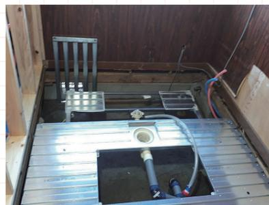
バリアフリーにするため、フローリングを解体し、新規に給排水設備の配管とバリアフリーになる高さで土間コンクリートを打ちました。
