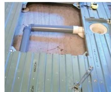
浴室床の排水溝から排水パイプをつなぐ配管の接続が終わった。排水が流れるよう、勾配を調整しながら設置していく。
