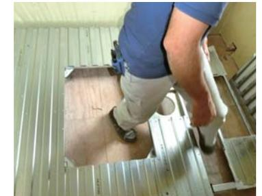
浴槽と洗い場を支える架台を設置。浴室と脱衣場の床の高さが水平になるように、架台についているボルト状の脚を調整している。
