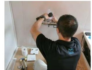
工事よいよ最終盤。水洗金具や給湯器のリモコン画面、天井には照明などを次々と取り付けていく。
