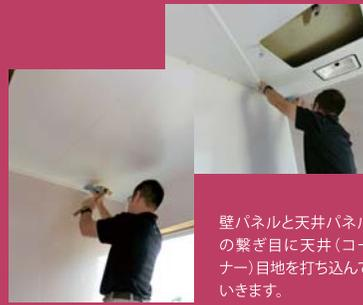
壁パネルと天井パネルの繋ぎ目に天井(コーナー)目地を打ち込んでいきます。
