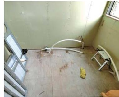
既存の浴室の解体が終わり、給水給湯配管の工事が終わったところ。洗い場を支える架台が置かれている。ここからシステムバスの組立作業が始まる。
