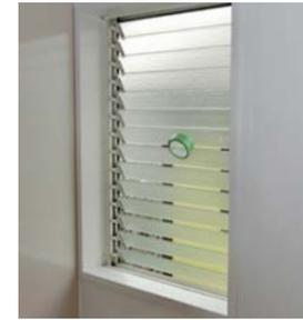
窓の大きさや奥行きに合わせて窓枠を加工。養生テープでジャロシ窓を固定している。
