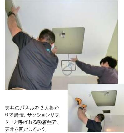
天井のパネルを2人掛かりで設置。サクシオンリフターと呼ばれる吸着盤で、天井を固定していく。
