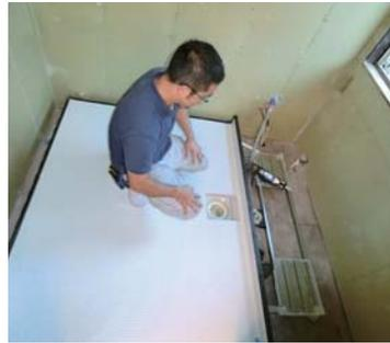
事前にセットしていた排水トラップに合わせて、床を設置。
