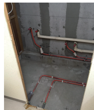
解体すると隠れていた配管や逆梁があるのがわかる。
